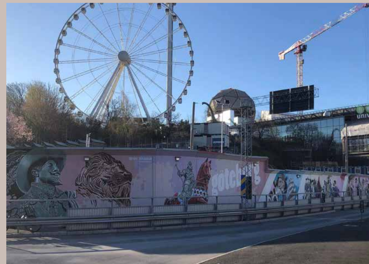
En annan välbekant utsmyckning, staketet som avskiljer bygget av Västlänken år 2021. Foto: Jacob Edwijn
